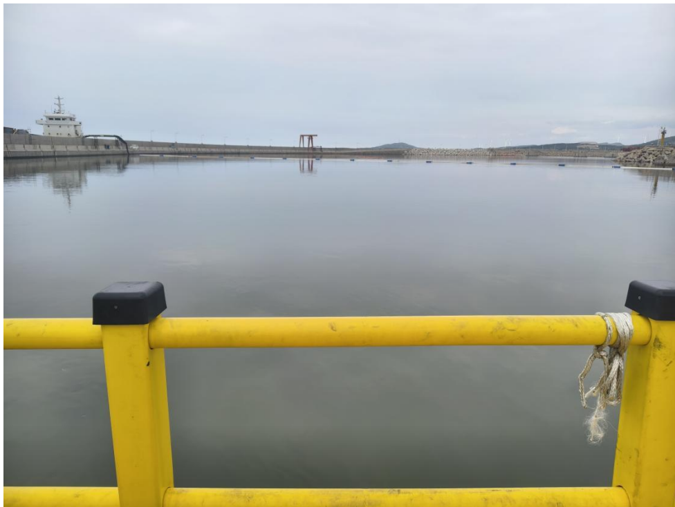
图 1.6-3 QCFS005TF 浮排周边海域使用现状（自西向东拍摄）
