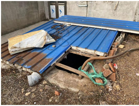
养殖散户污水暂存池
