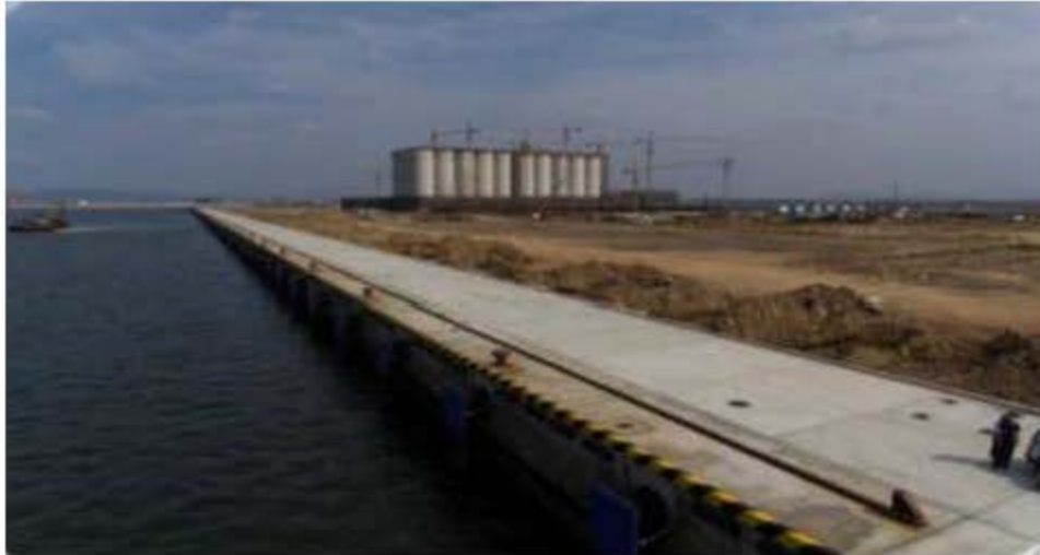
图 2.1-6 散粮码头建设现状
